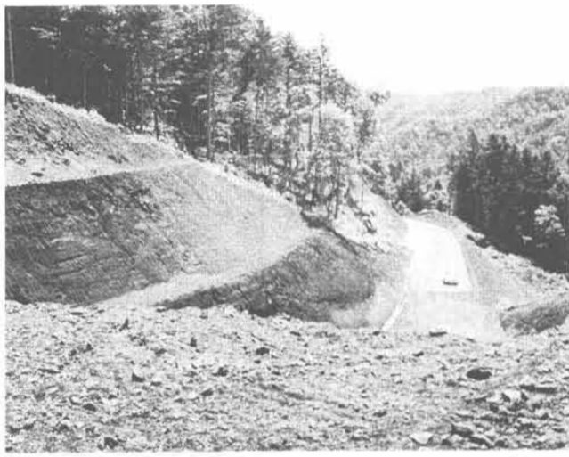
原生林を開いて工事中の大規模林道(置戸・阿寒線)
